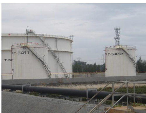
รูปที่ 3-22 ถังเก็บน้ำเสียจากกันถังคอนเดนเสท
