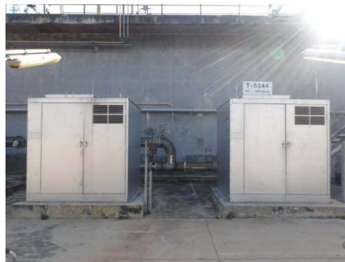
รูปที่ 3-14 การปิดครอบเพื่อลดระดับเสียง ที่แหล่งกำเนิด
