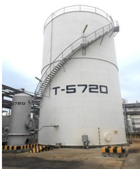
รูปที่ 3-18 Ballast Tank (T-5720) รวบรวมน้ำเสียปนเปื้อนน้ำมันจากเรือ
