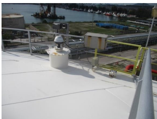
รูปที่ 3-49 Over Fill Protection บริเวณถังกักเก็บ
