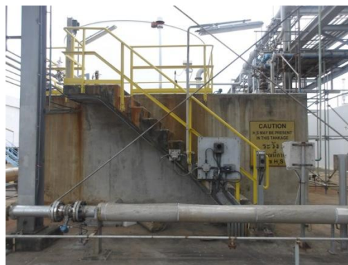
ระบบ Neutralization Basin
