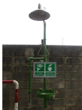
รูปที่ 3-39 อุปกรณ์ดับเพลิง และ Safety Shower & Eye Washer ในพื้นที่รวบรวมกากของเสีย
