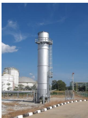
รูปที่ 3-9 ระบบ Vapor Combustion Unit หน่วยที่ 1 (VCU-1)
