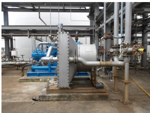
รูปที่ 3-26 เครื่องอัดอากาศ (Compressor) ของถัง H 2 S Oxidation (K5502)
