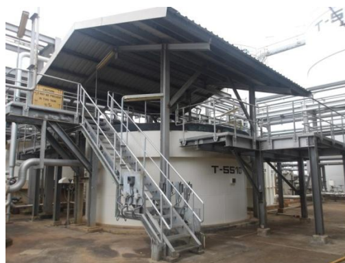
ระบบ Flocculation-Flotation (FFU)
