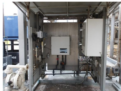
รูปที่ 3-27 Conductivity Meter และ pH Online ที่บริเวณจุดระบายน้ำ Blowdown
