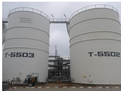
รูปที่ 3-25 ถังรองรับน้ำ Off-Spec.
